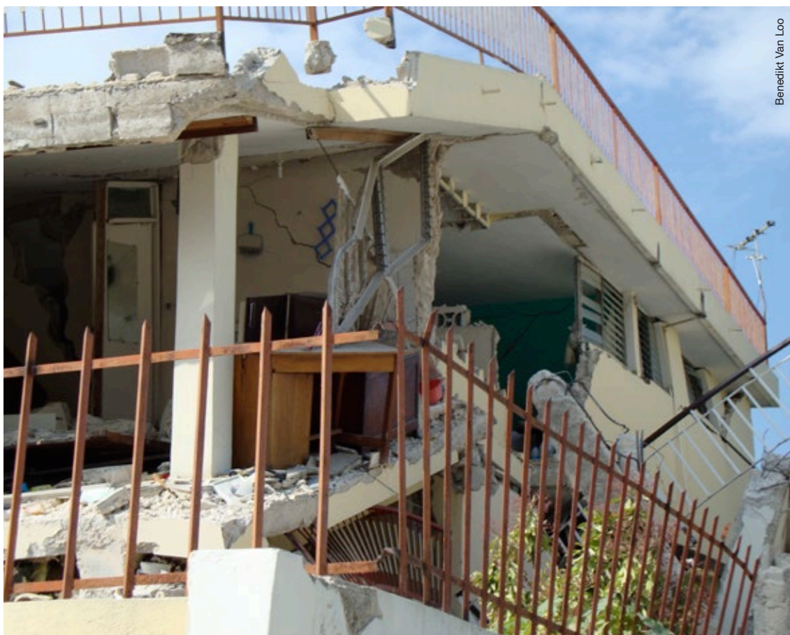
Bâtiments détruits en Haïti suite au tremblement de terre de 2010.
